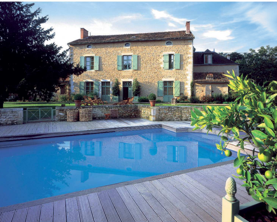
L'Hôtel Les Orangeries à Lussac les Châteaux, multiplie les initiatives dans le domaine du développement durable
